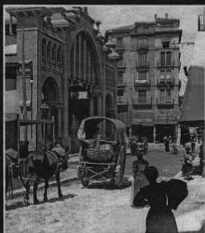
Fachada del edificio del mercado. S.F.
